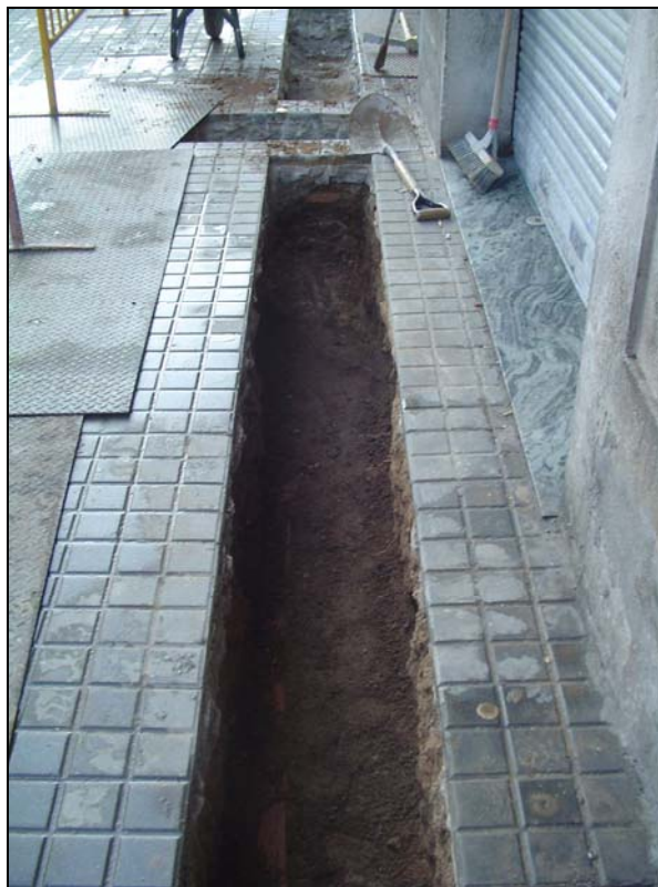
Foto 6: Detall de la rasa a la Rambla núm. 93-91.
