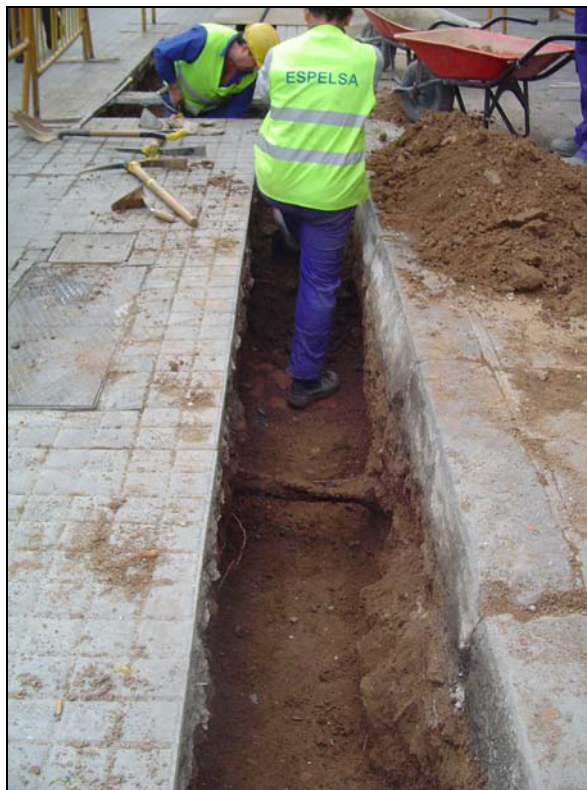
Foto 4: Detall de la rasa durant els treballs constructius al núm. 97-95 de La Rambla.
