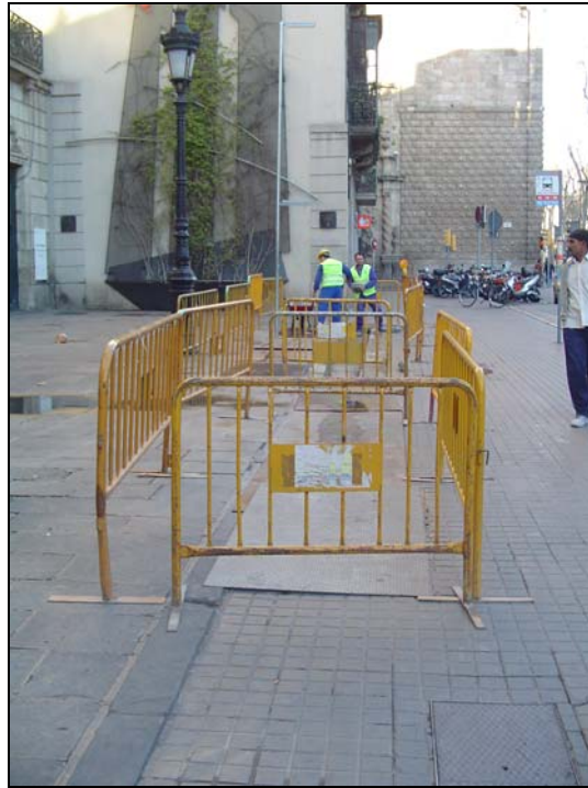
Foto 1: Vista general del la rasa a La Rambla davant del Palau de la Virreina (núm. 99).
