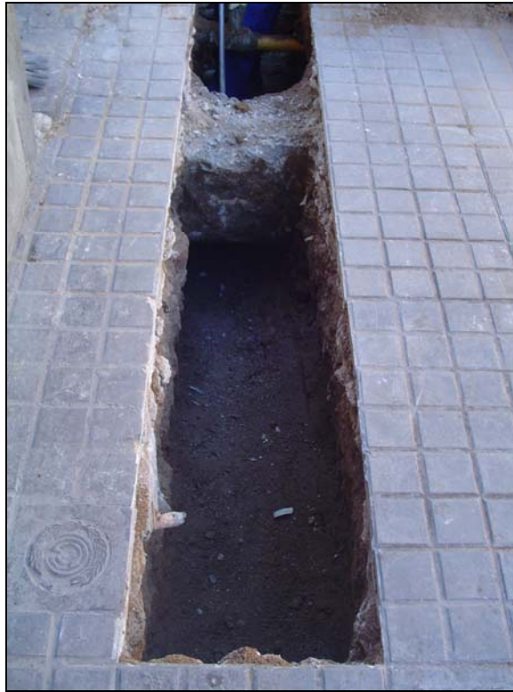
Foto 3: Rebaix efectuat a La Rambla núm. 97-95.
